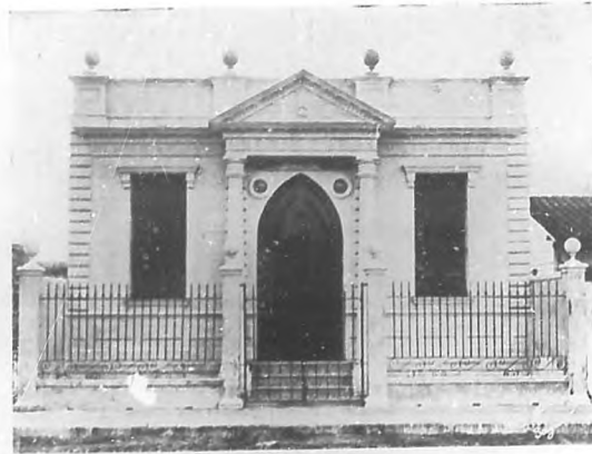
Fachada principal de la Logia "Hijos de la Fe", en Sagua.
