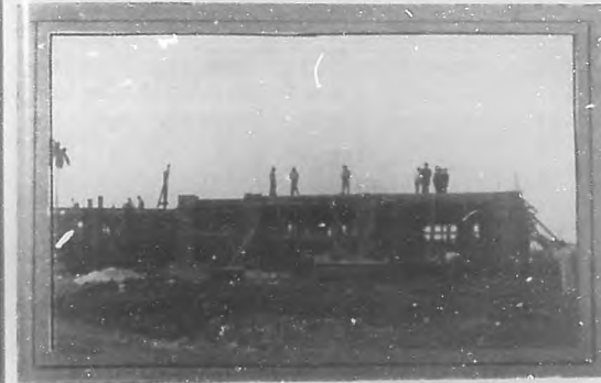
EL HIPÓDROMO DE MARIANAO.—Cimientos para el gran edificio de tres pisos que se construye para la "Casa Club".
